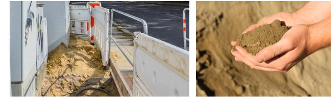
Der Bodenaushub, der bis jetzt deponiert wurde, kann nach erfolgter Qualitätskontrolle durch ein unabhängiges Ingenieurbüro wieder eingesetzt werden. Nur ein einwandfreier Qualitätsbaustoff geht als „GWM-Sand“ zur Baustelle des Kunden zurück.
